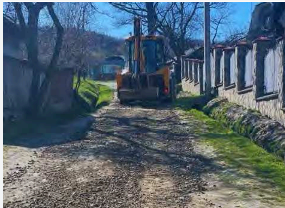
Ремонт дорожнього покриття
