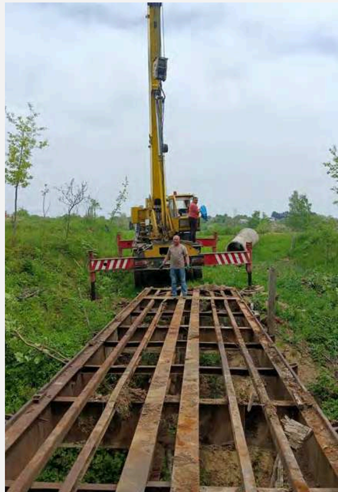
Встановлення залізної платформи для відновлення моста в урочищі «Чертежі»
