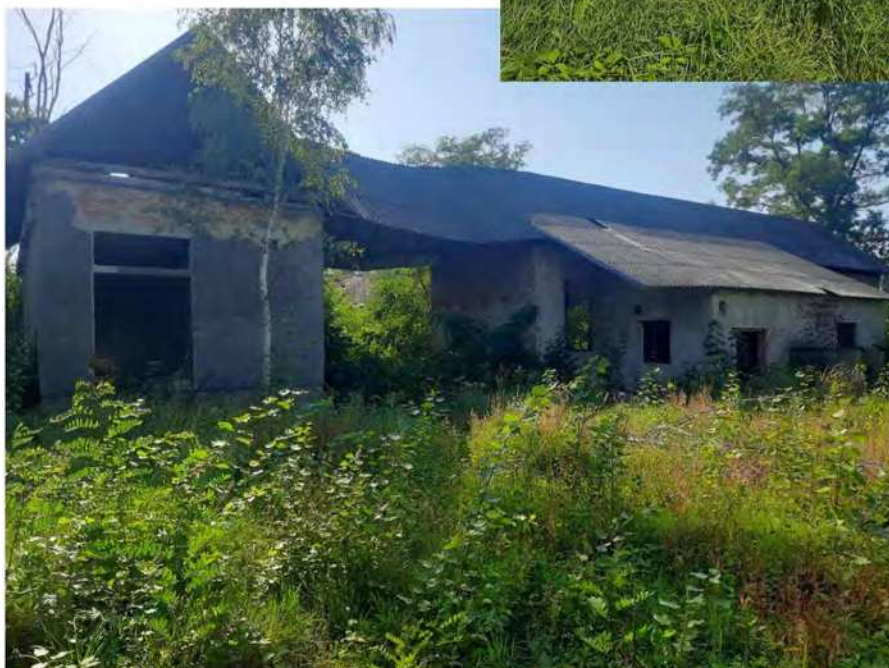
Фото 4. Котельня, пустуюче приміщення
