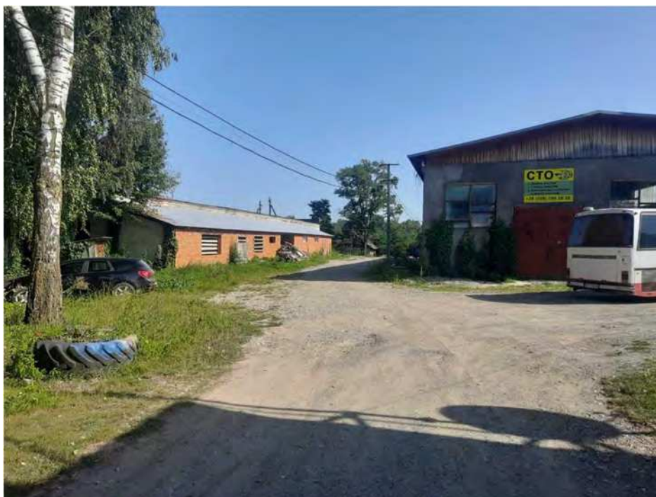
Фото1. Пустуючі виробничі приміщення
